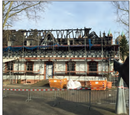
Der Dachstuhl des denkmalgeschützten Kutscherhauses am Fischmarkt ist komplett abgebrannt. Foto: Jansky
